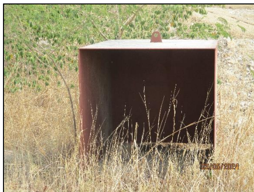
รูปที่ 2-23 กำบังสำหรับหลบขณะทำการระเบิด
