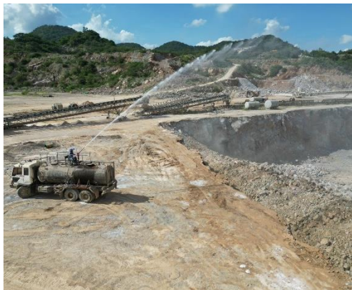
รูปที่ 2-44 ปืนฉีดน้ำแรงดันสูงฉีดกลุ่มฝุ่นละอองขณะทำการระเบิด
