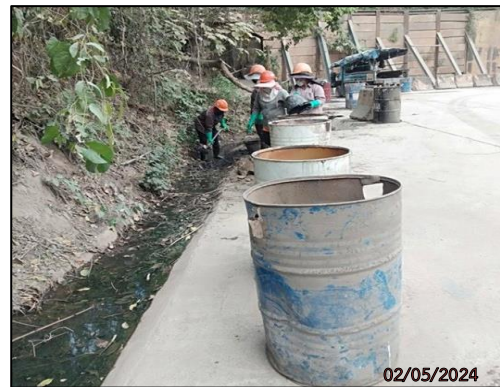
รูปที่ 2-24 การขุดลอกตะกอนดินในคูระบายน้ำของโครงการ
